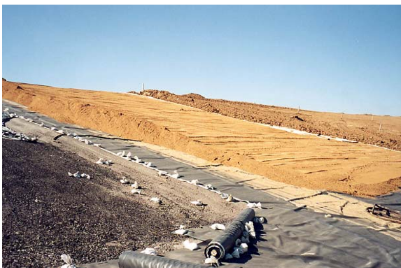
Figuur 3.2: Aanleg afdichtingslaag (minerale laag en folie)
