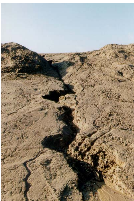
Figuur 4.3: Erosie door extreme neerslag tijdens aanleg bovenafdichting
